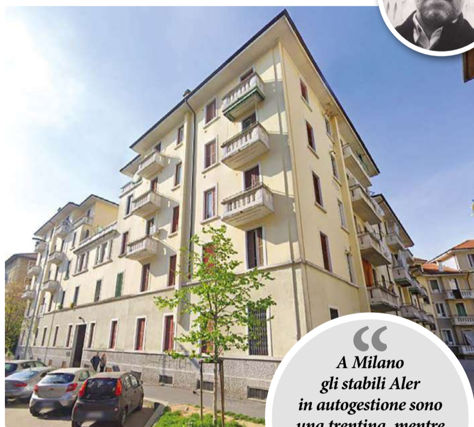
Sotto, l'edificio di via Panigarola 4, al Corvetto.
